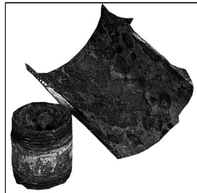
Korrosionen an Rohrleitungen
