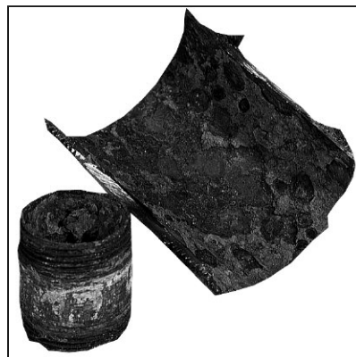
Korrosionen an Rohrleitungen
